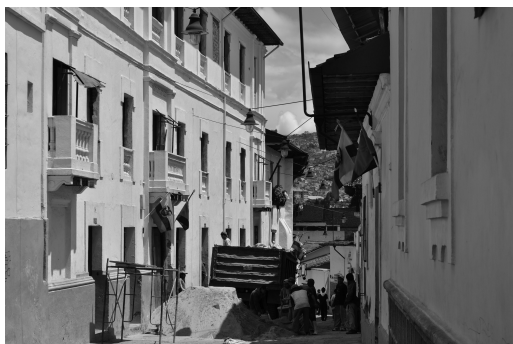
Rehabilitación de casona destinada a un Hotel Boutique. Fotografía: Lucía Durán, 2012.
