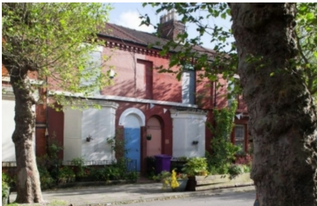
Estat dels edificis després del procés
