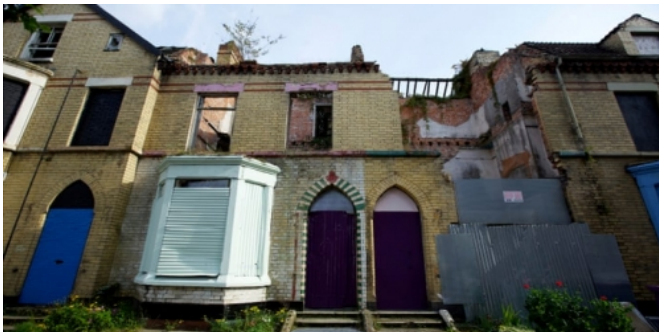
Estat dels edificis abans del procés de rehabilitació
